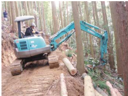
バケットによる転圧
