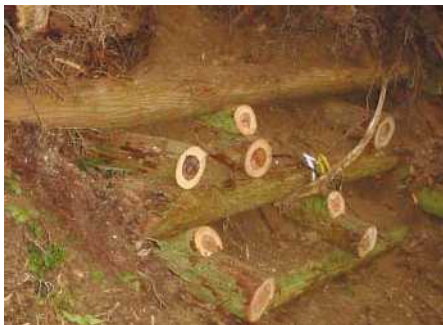
現地発生木材を利用した丸太組構造物
