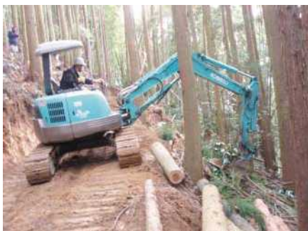
バケットによる転圧
