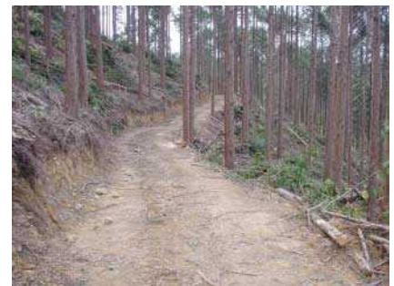
必要最小限の伐開幅で道脇の立木を保残するとともに、切り土高を抑えて災害に強い作業道を開設します。
